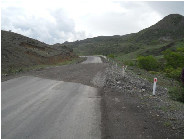
სურ. 50. მეწყრისგან დაზიანებული ახალციხე-ასპინძის საავტომობილო გზა
