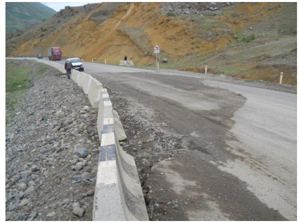
სურ. 51. მეწყრისგან დაზიანებული ახალციხე-ასპინძის საავტომობილო გზა
